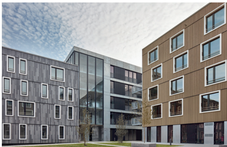
Holz und Beton: zwei Werkstoffe, die sich bei beim seriellen Bauen in Holz-Hybrid-Bauweise perfekt ergänzen
