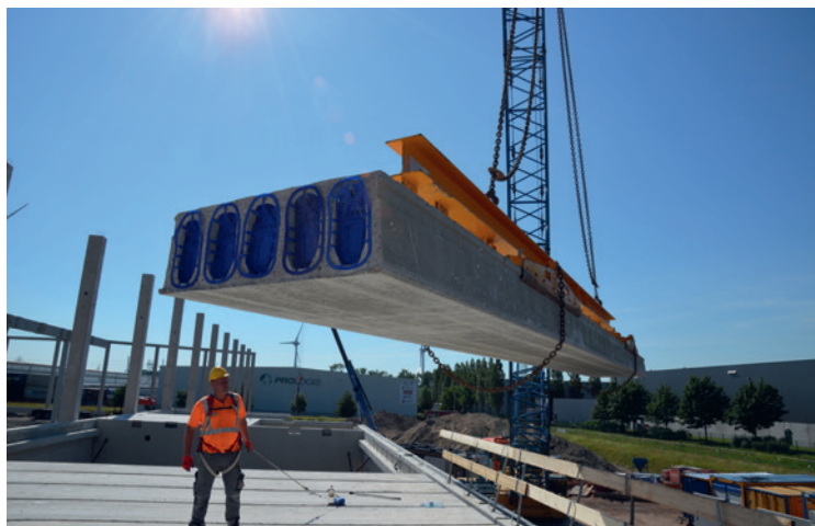
Die Montage von BRESPA®-Spannbetondecken braucht nur einen Bruchteil der Zeit, die herkömmliche Betondecken erfordern. Darüber hinaus werden durch die Hohlkammerkonstruktion bis zu 50% Beton sowie durch die Vorspannung bis zu 85% Stahl eingespart
