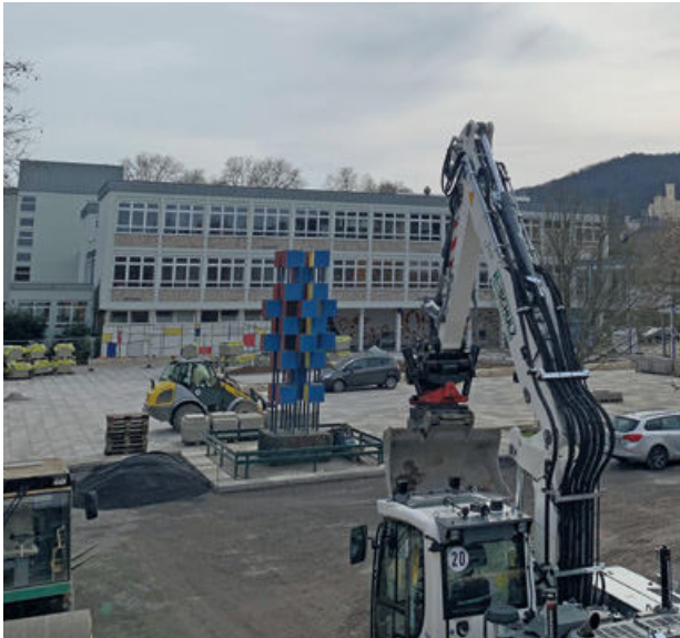
Ein Überblick über den Schulhof. Im hinteren Bereich ist das neue Pflaster bereits verlegt.
