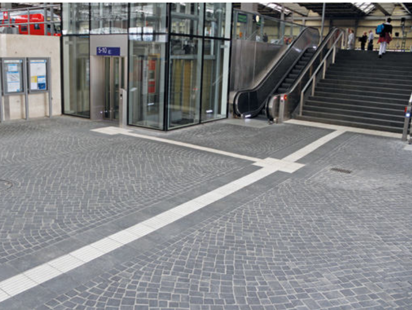
Begleitstreifen unterstützen die Erkennbarkeit von Bodenindikatoren.
