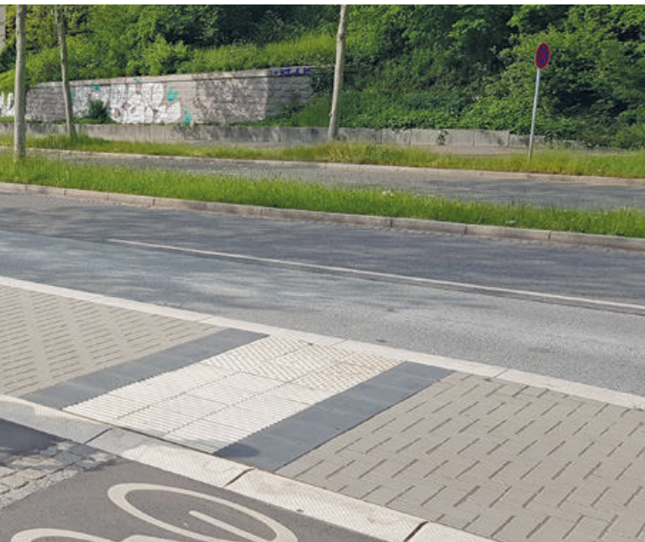
Abgrenzung von Rad- und Fußgängerweg.
