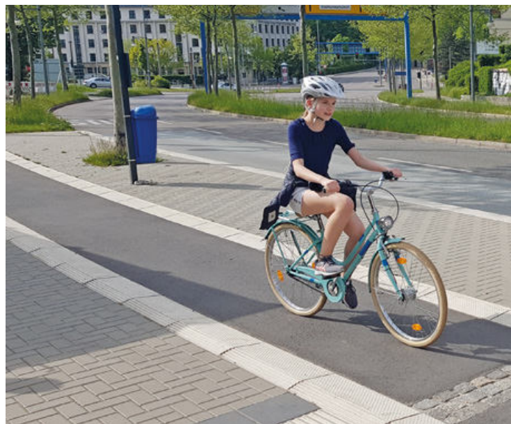
Bei gleichem Bodenniveau dient eine Radwegplatte als Begrenzungsstreifen zur Trennung.
