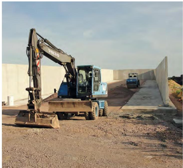
Fahrsilobau mit Fertigteilwänden.
