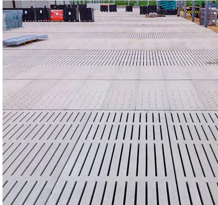
Spaltenböden mit unterschiedlichen Öffnungsanteilen.
