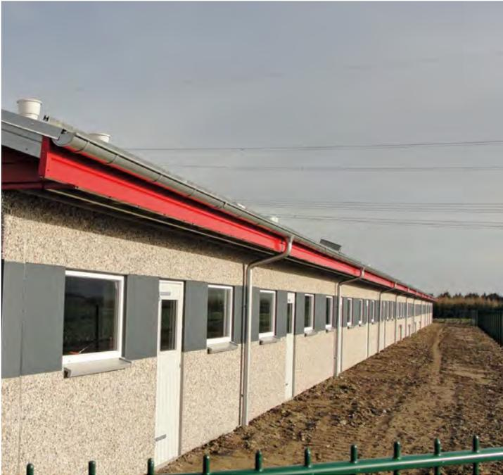
Schweinstall mit wärmedämmten Wandfertigteilen.
