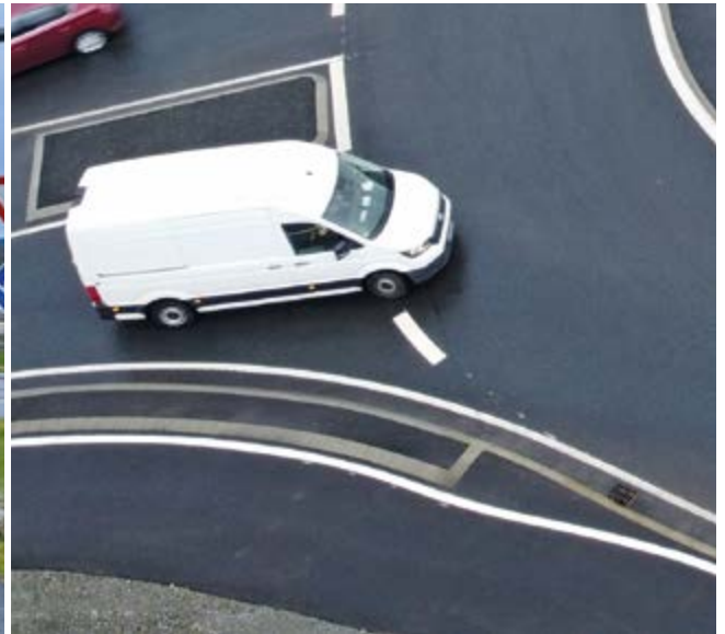
Überfahrbare Randstreifen ermöglichen ein ordnungsgemäßes Passieren des KVP durch Schwerlastfahrzeuge.
