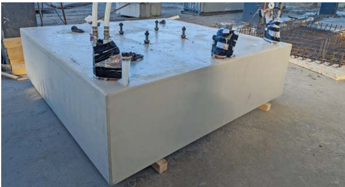
Vorgefertigter Fundamentblock für die Säule.
