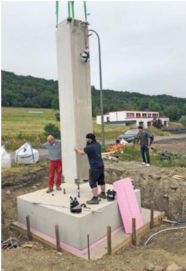
Montage der vorgefertigten Bauteile für die Säule.
