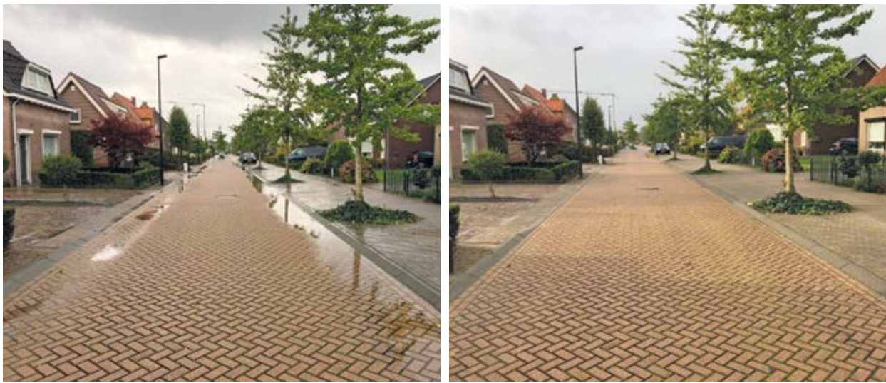
Wasserdurchlässiger Pflasterbelag in den Niederlanden direkt nach Starkregen und fünf Minuten später.
