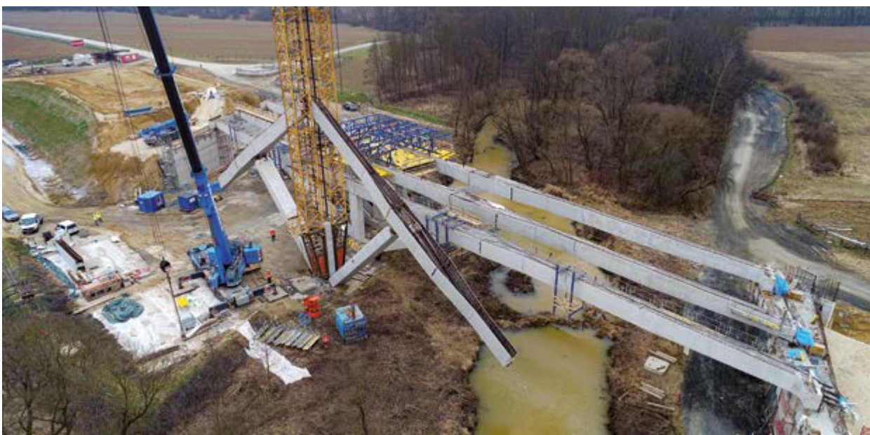
Aufklappvorgang der Lahnbachbrücke.
