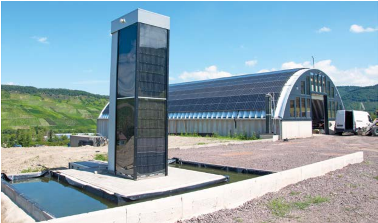
Die Energiesäule im Umfeld weiterer Energieerzeuger auf dem Gelände der Innogration GmbH.
