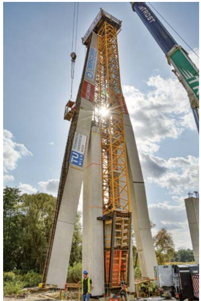
Der erste von vier Brückenträgern unmittelbar vor Beginn des Ausklappverfahrens.
