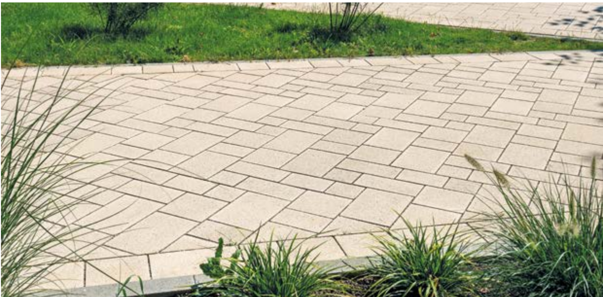
Wasserdurchlässiger Pflasterbelag mit allgemeinen bauaufsichtlichen Genehmigungen.
