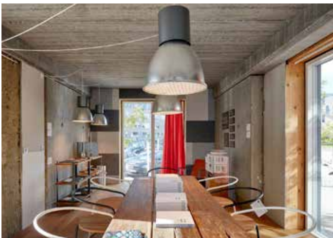
Musterwohnraum mit sichtbaren Spannbeton-Fertigdecken
