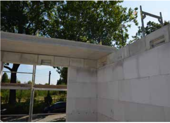
Alle Bauteile sind demontierbar und lassen sich mehrfach einbauen, Foto: DW SYSTEMBAU
