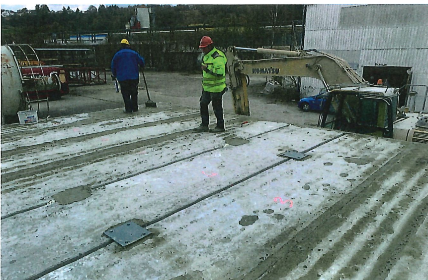
Verschiedene Varianten der Fugenausbildungen. Foto: BVSF
