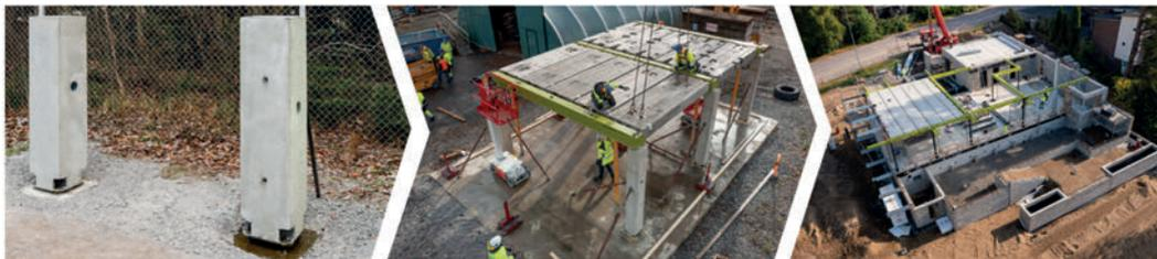
**Pilotversuch 1: Montage von Fertigteilstützen, 2019**
